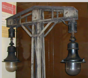
Bogenlampe Gleisfeldbeleuchtung der Betriebswerkstatt Seestraße von 1925 - 1977 in Betrieb
